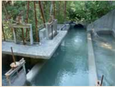
Doc n° 27 : photographie d'un embranchement du canal de la Plaine et du Bourtanic, à Montmaur, sur le torrent de la Béoux ; le canal principal se trouve au centre, tandis que la rigole secondaire se trouve à gauche, en contrebas, fermée par des éanches en martelière, 2010.
