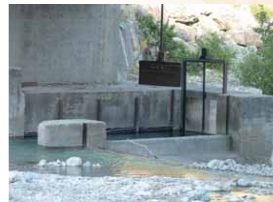
Doc n° 26 : photographie de la prise d'eau du canal de la Plaine, à Montmaur, sur le torrent de la Béoux ; la prise se trouve à gauche du barrage, protégée par un tunnel et une martelière, 2010.
