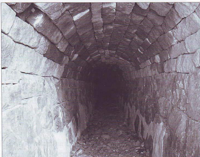
Dans le tunnel supérieur
