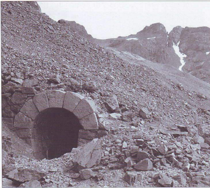
Sortie du tunnel supérieur
