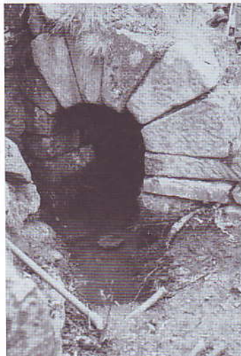
Le niveau d'origine est atteint sous le tunnel
